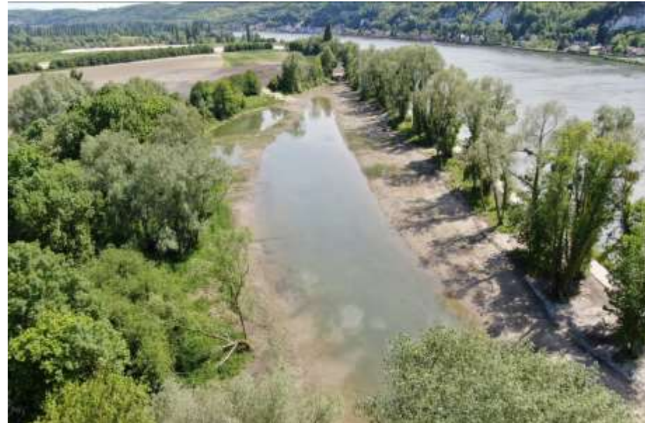
Restauration écologique d'une annexe hydraulique à Sahurs
